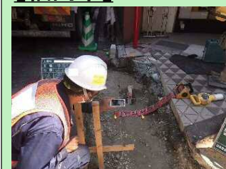
【検査状況（現場側）】
