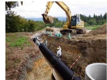
排水構造物工（暗渠排水管）
