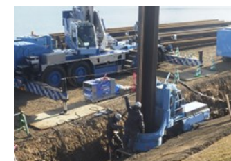
油圧圧入引抜工
